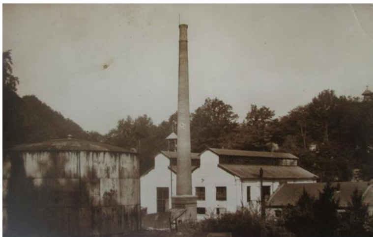
Fig. 4 - Uzina electrică-Băile Govora, 1947 13
