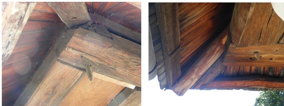
Fig. 5: Clous en bois pour la charpente du toit
