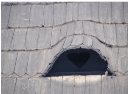
Fig. 4: Les ouvertures de la toiture
