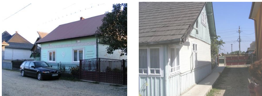
Fig. 13: Maisons « allemandes » (enduite- gauche, et couverte d'un bardage - droite)
