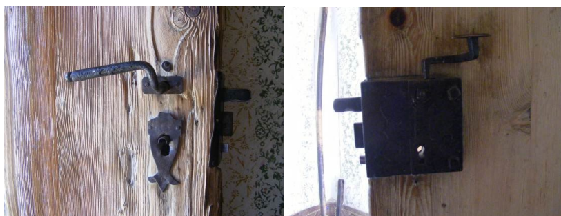
Fig. 9: Poigné de la porte d'entrée d'une ancienne maison « roumaine »
