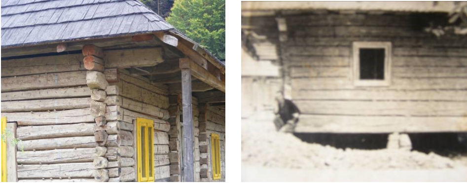
Fig. 6: Jonctions des poutres horizontales (à droite - ancienne photo)
