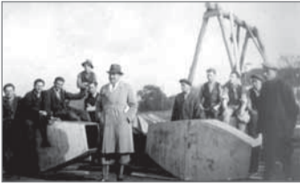
Echipa de montaj la descărcarea modulelor
