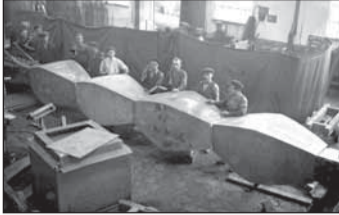
Montajul de probă al Coloanei în atelierul de construcții metalice al Atelierele Centrale Petroșani
