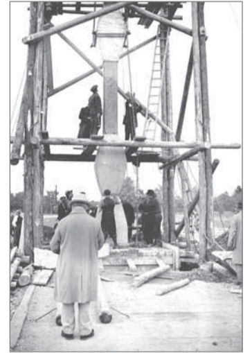
Cel de-al doilea element se lasă în jos pe stâlp
