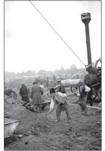
Organizarea șantierului de montaj al Coloanei la Târgu-Jiu
