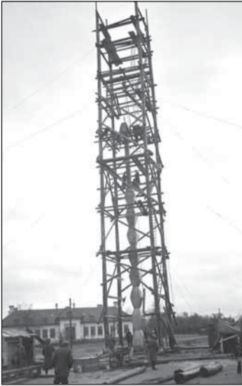
Tragerea pe stâlp a celui de al optulea element
