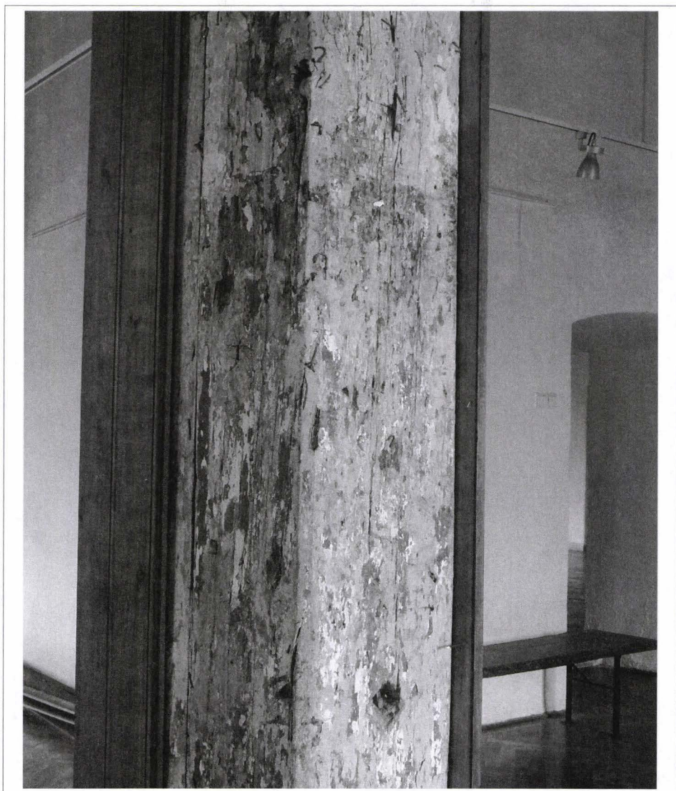
4. kép. A többszörösen lefestett oszlop felülete (részlet)
