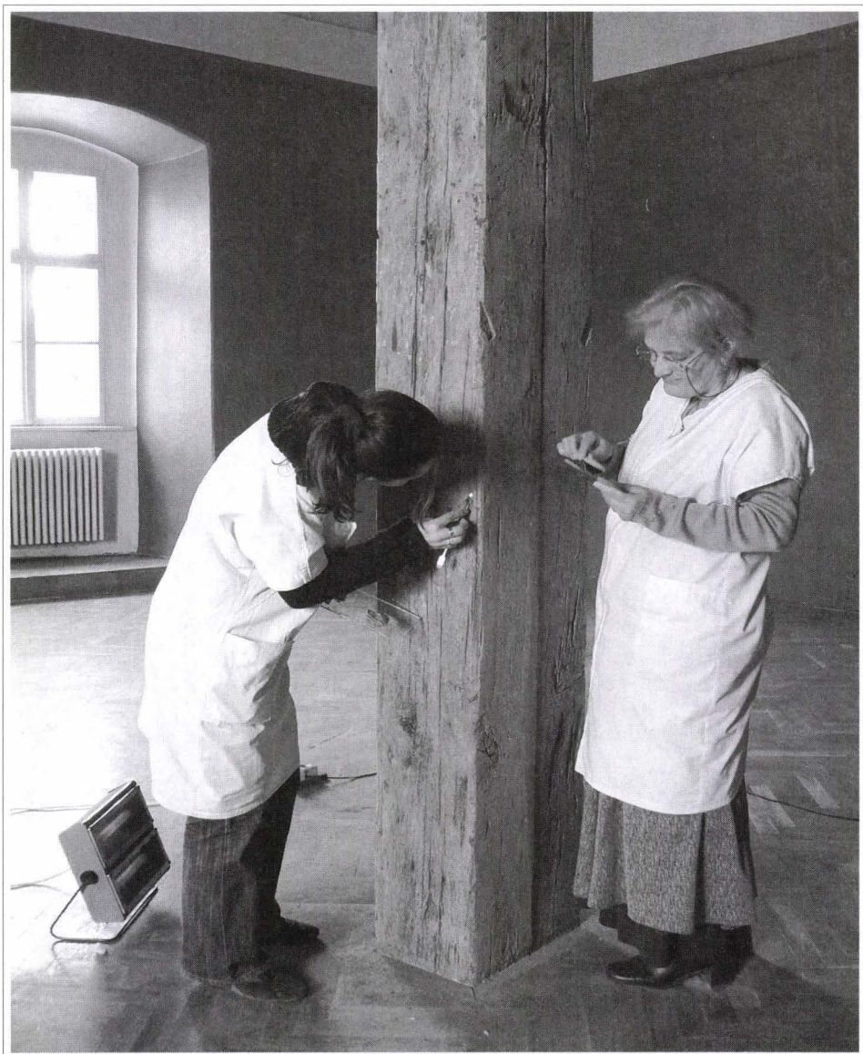
11. kép. A kisebb hiányok kiegészítése fatapasszal
