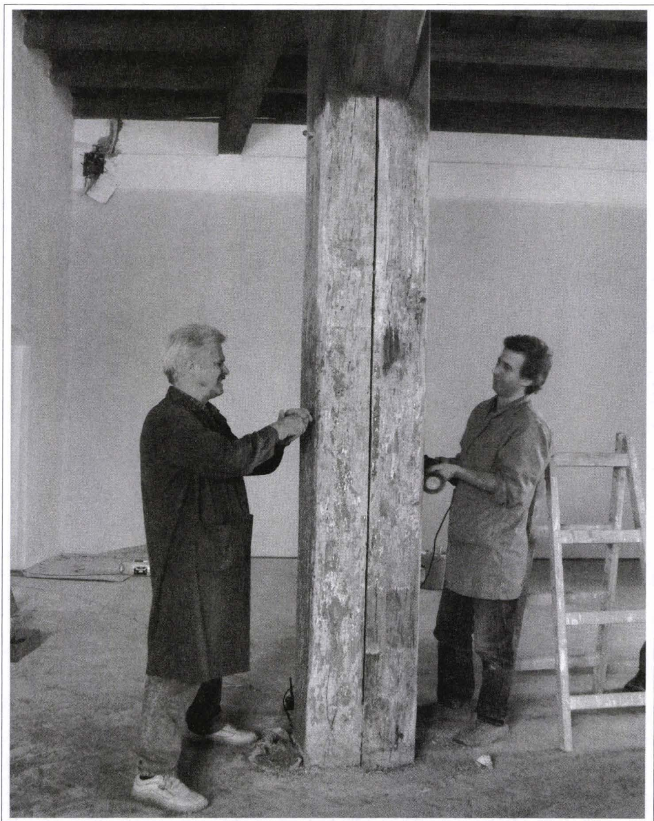
6. kép. Az oszlop mechanikai tisztítása
