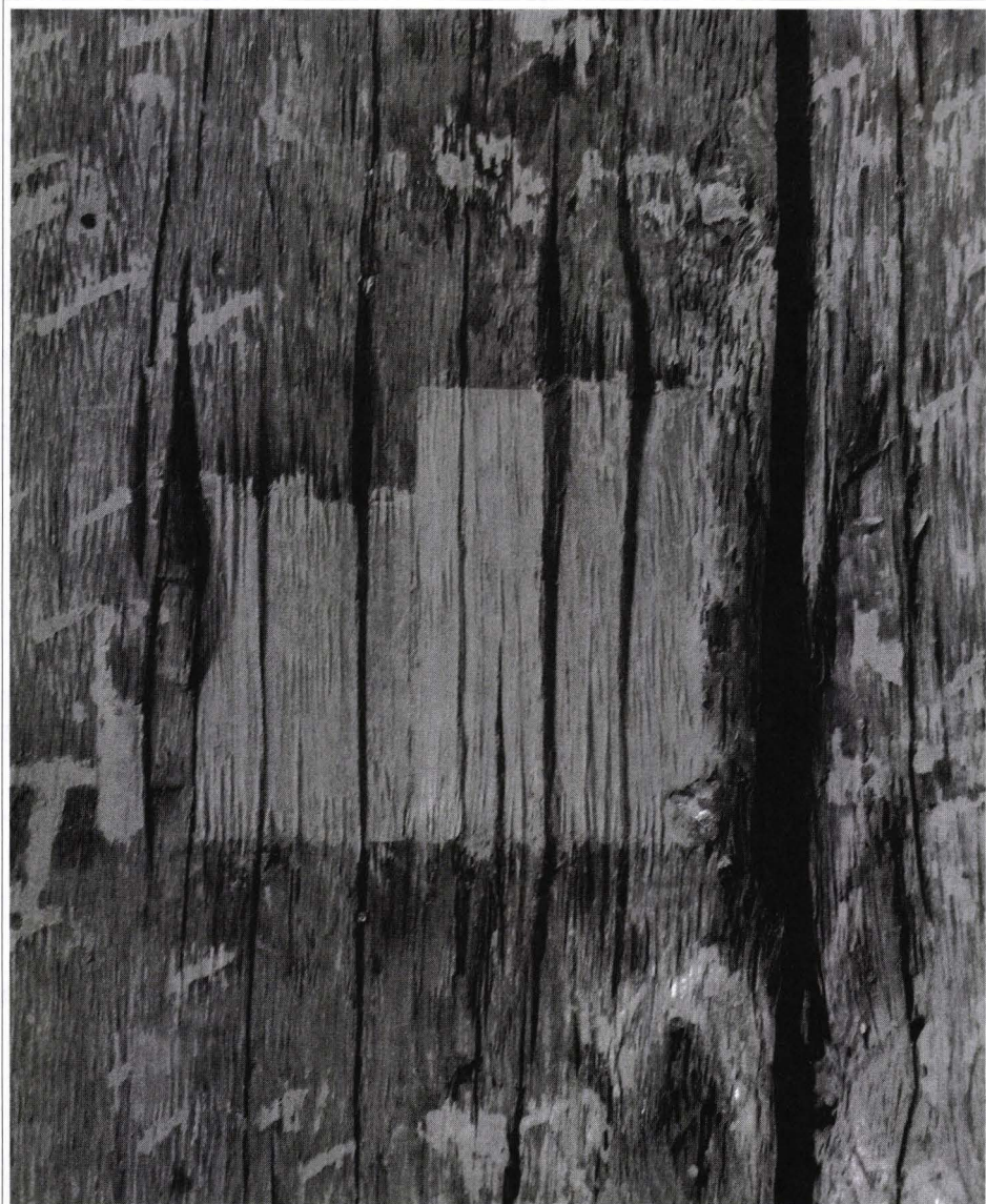
9. kép. Az eredeti faoszlop erezetének imitálása a pótláson
