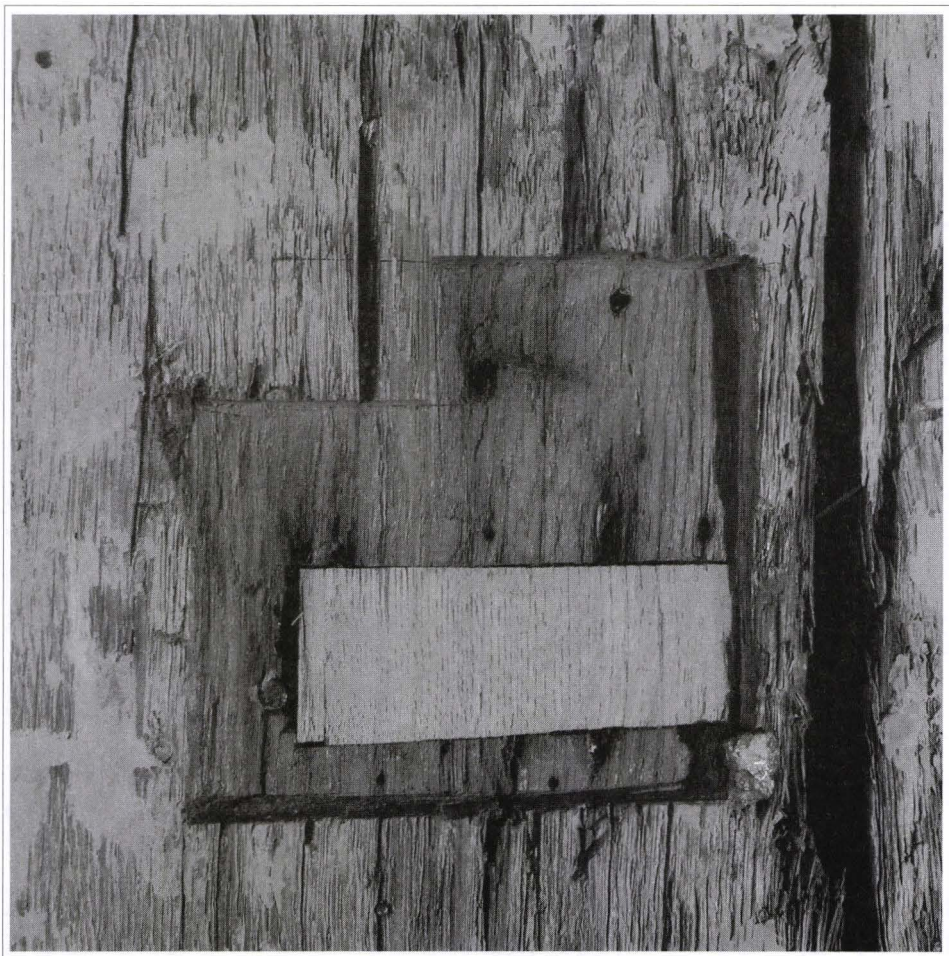
8. kép. A hiányzó részek fával való kiegészítése
