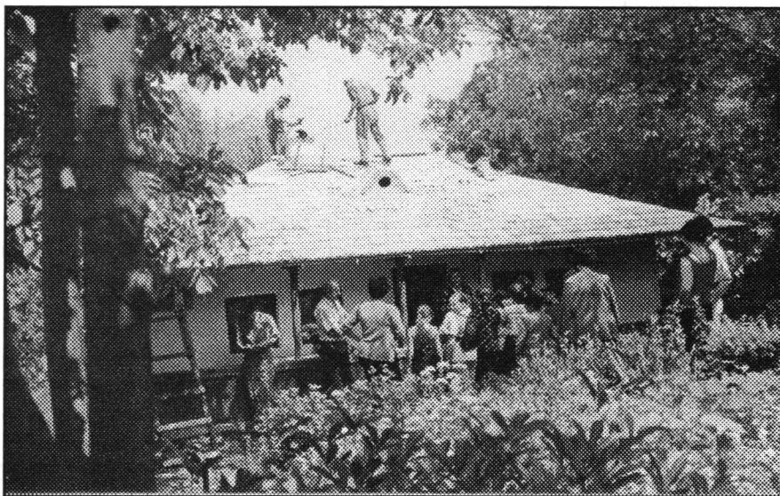
Bojdeuca „Ion Creangă” din Țicău are un nou acoperiș. În lunile acestei veri, vechiul acoperiș a fost înlocuit cu draniță adusă de la Borca-Neamț. Mulțumim și pe această cale prietenului nostru, poetul Radu Florescu și echipei de profesioniști (frații Maxim), cu sprijinul cărora a fost realizată restaurarea acoperișului Bojdeucii. (D.C.)
