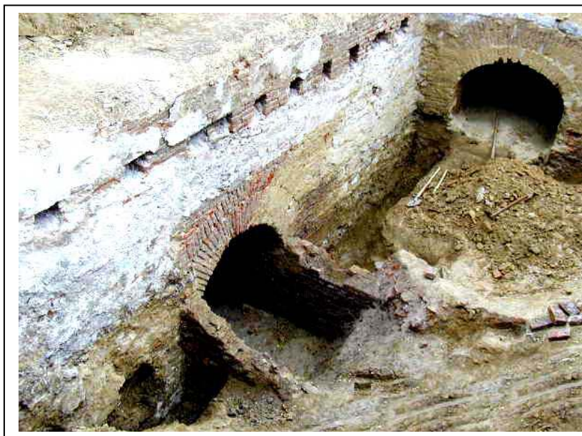
Fig. 3. - Piața agroalimentară Mazepa I – Fundațiile și beciurile construcției
