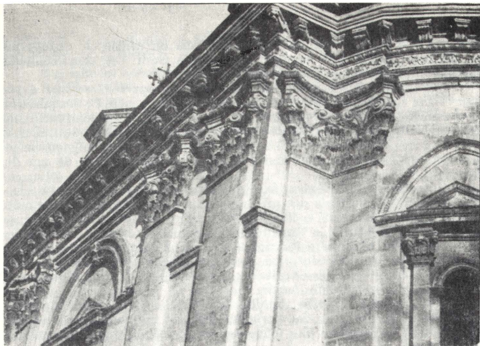
Fig. 2. Eglise du monastère de Golia. Façade sud, détail. Raccordement du naos et de l'abside du sanctuaire (photo de l'auteur).
