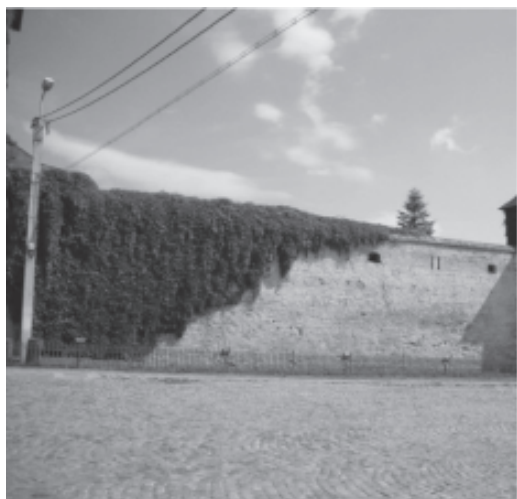
▪ Zidul sudic văzut din exterior
