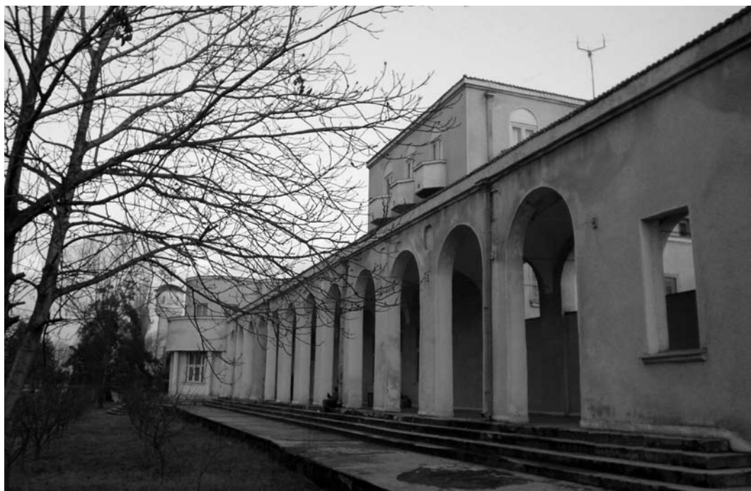
Pavilionul comandament (1939) – latura dinspre terenul de educație fizică cu terasa acoperită
