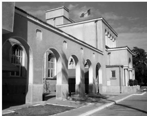
Pavilionul comandament (1939) – latura dinspre linia de centură cu intrarea principală și terasa descoperită
