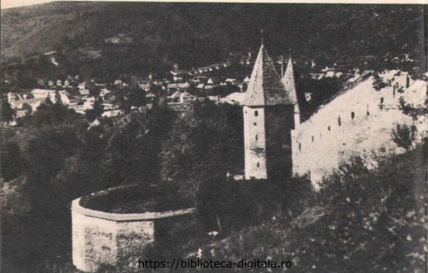
Turnul și bastionul Măcelarilor (sec. XVI)
