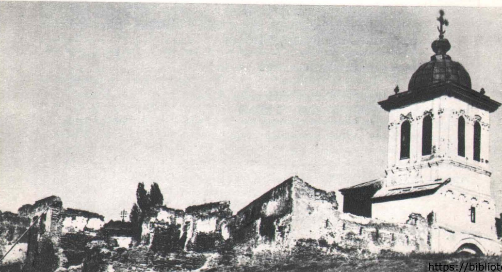
2. Latura de sud-vest a mănăstirii — înainte de restaurare
