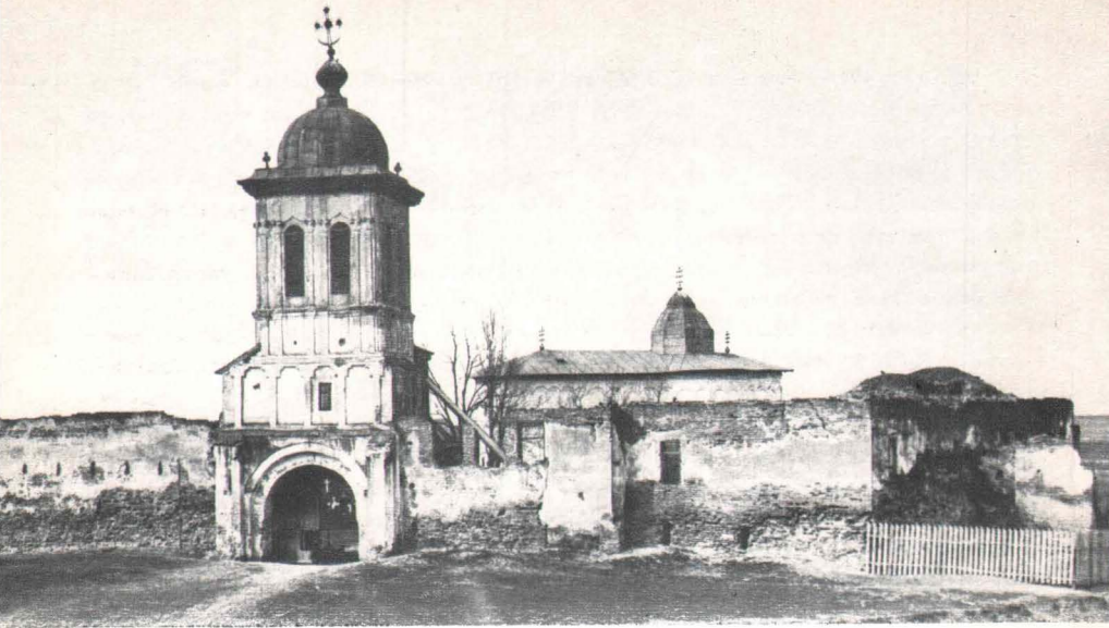
1. Vedere generală a mănăstirii — înainte de restaurare
