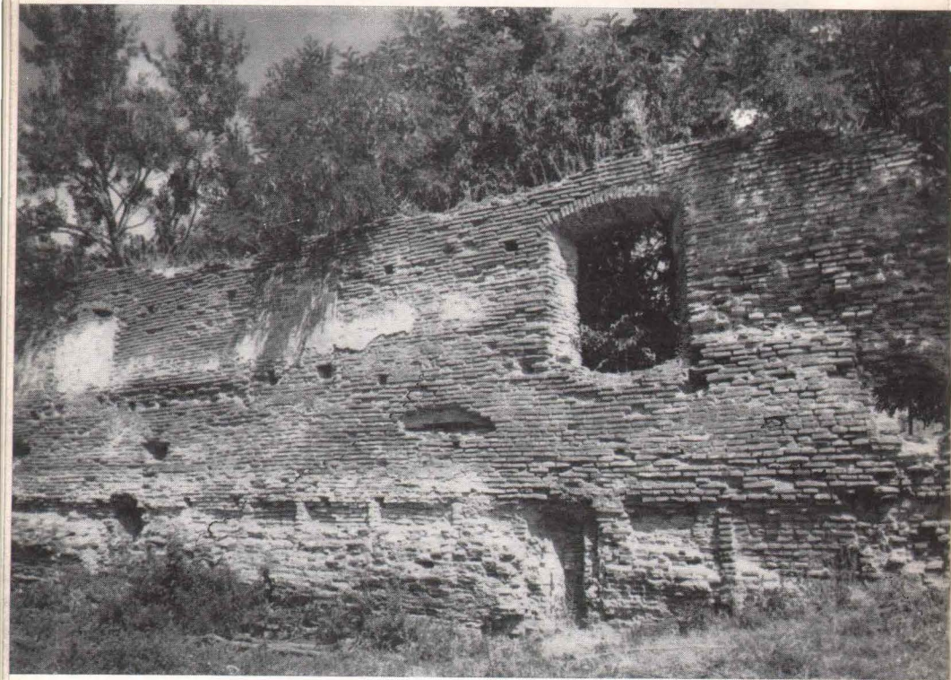
12. Ruines du mur d'enceinte — côté nord de la cour
