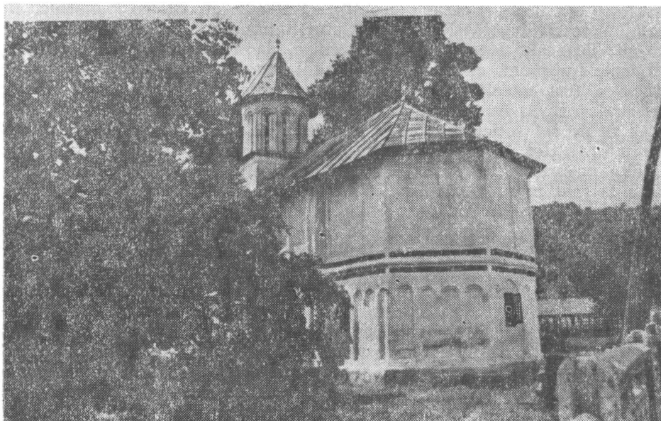
Fig. 7. — Absida altarului la monumentul de la Sîmburești. Vedere dinspre sud-est, dinspre vale, a părții de zid ce a fost îngroșată pentru sporirea rezistenței.
