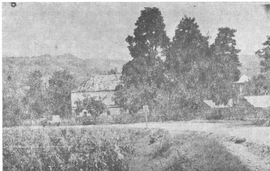
Fig. 8. — Monumentul de la Sîmburești. Vedere de ansamblu, dinspre nord. Se vede înclinarea pantei către sud, după linia drumului, care coboară dinspre dreapta spre valea riului Cungrea. Această înclinare a necesitat îngroșarea zidului absidei altarului spre sud-est, pentru mărirea rezistenței.
