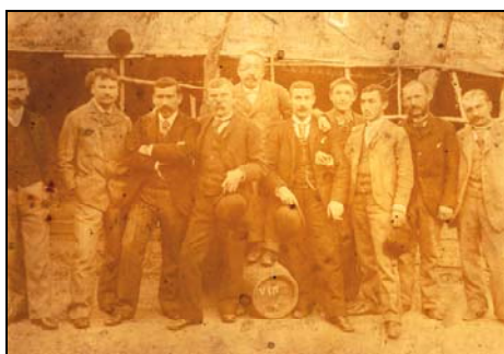
2. Colectivul de arhitecți care au lucrat la construirea Palatului Poștelor (Alexandru Săvulescu (lângă butoi, stânga), Z. Koszynsky, Alois Pechs, B. Sontag) - Fotografie din patrimoniul M.N.I.R. The architects working for the building of the post Palace - Photography from the National History Museum of Romania heritage
