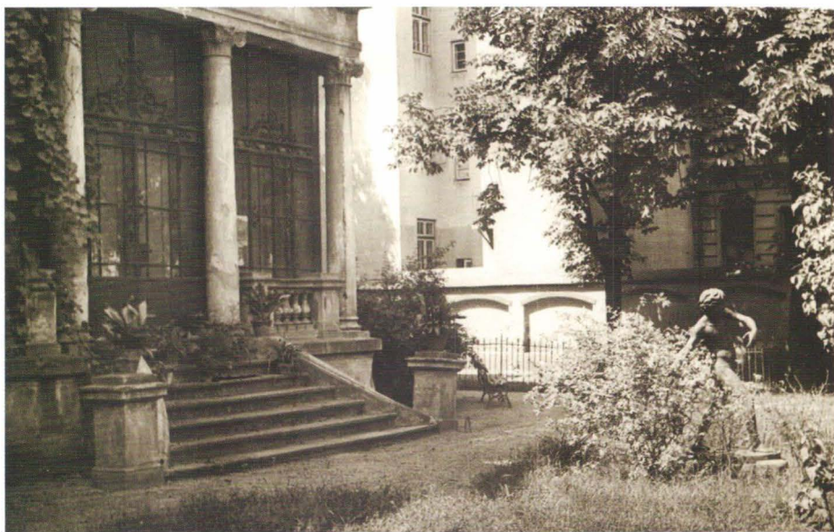
19. Colț din curtea casei lui Nicu Cerkez, cu intrarea principală și statuia Aruncătorul de suliță , de Ion Georgescu. Fotografie realizată de Felix Anton (Studio Ordinea, București). A corner of the garden of Nicu Cerkez's house, with the main entrance and the statue The Javelin Thrower by Ion Georgescu. Photograph taken by Felix Anton (Studio Ordinea, Bucharest)
