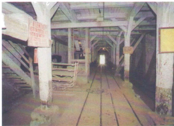
Fig. 3: Parter – se observă șinele pentru cărucioarele de transport cărămida.
