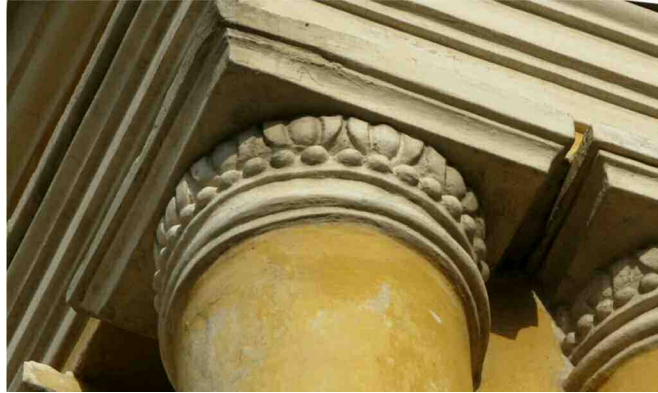
Fig. 7. Capitel de pe fațada de sud, rezalitul central
