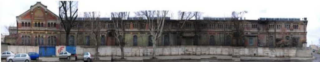
Fig. 2. Uzina Electrică Filaret. Desfășurare pe strada Candiano Popescu
