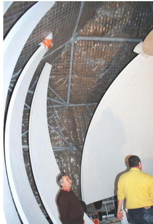
Poza nr. 2. Montarea cupolei.
