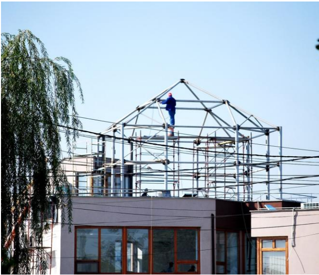
Poza nr. 1. Construcția Planetariului Bârlad.
