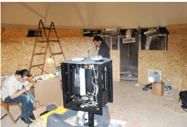
Poza nr. 3. Montarea echipamentelor.
