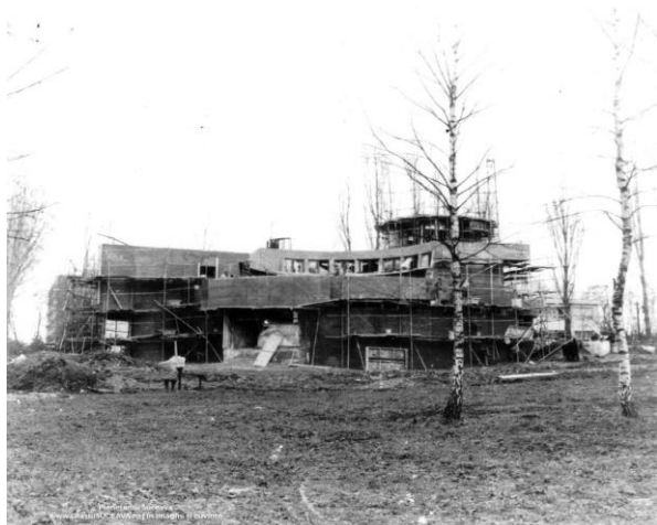
Imaginea nr. 1 Faza de construcție în 1979
