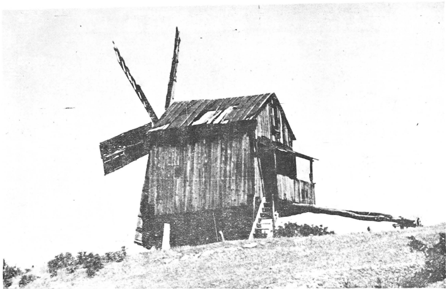
Fig. 5. Moara de vânt mică pe soclu de piatră de la Mănăstirea Cilic, jud. Tulcea.
