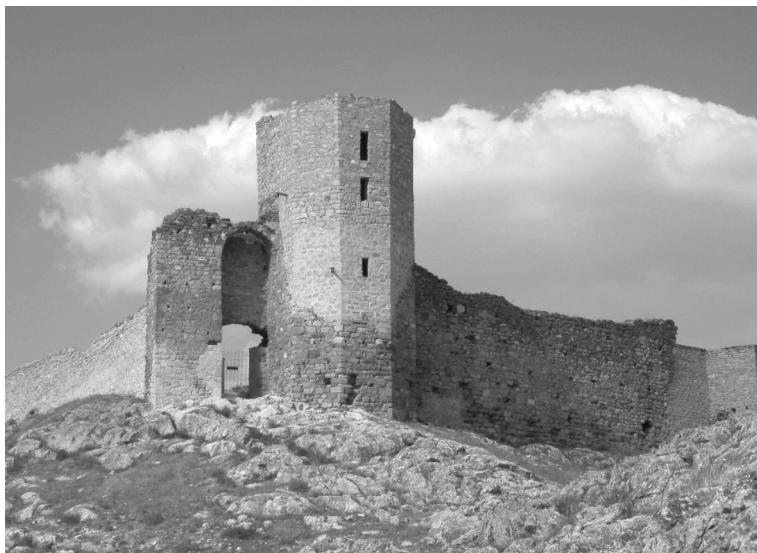
Fig. 7. Cetatea de la Enisala, în anul 2009. Se observă turnul poligonal restaurat. Fig. 7. The fortress of Enisala in year 2009. Note the restored polygonal tower.
