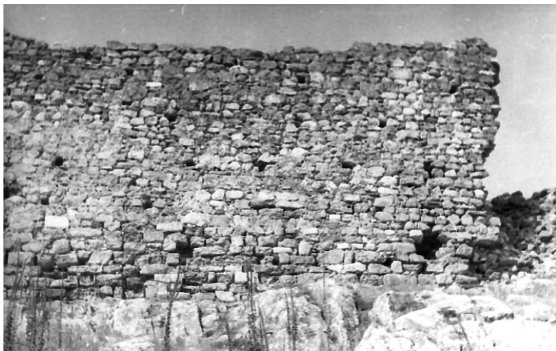
Fig. 4. Curtina 1, vedere exterioară, în anul 1992. În alcătuirea acesteia intră ~61% calcare cenomaniene, ~25% roci turoniene, ~9,5% calcare triasice și 4,6% calcare sarmațiene.
