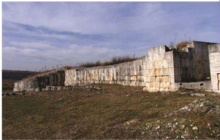
Fig. 1. 1. Vedere aeriană a sectorului C I de la cetatea Tropaeum Traiani; 2. Poarta de sud și o parte din incinta de sud-vest a cetății TropaeumTraiani / 1. Aerial view of TropaeumTraiani C I sector; 2. The southern gate and part of the south-west enclosure of TropaeumTraiani.
