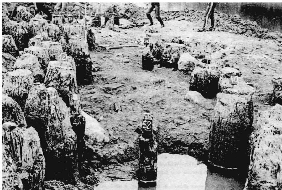
Fig. 20 - Piloni de lemn ai instalației portuare de la *Siscia* (Sisak – Kovnica).
