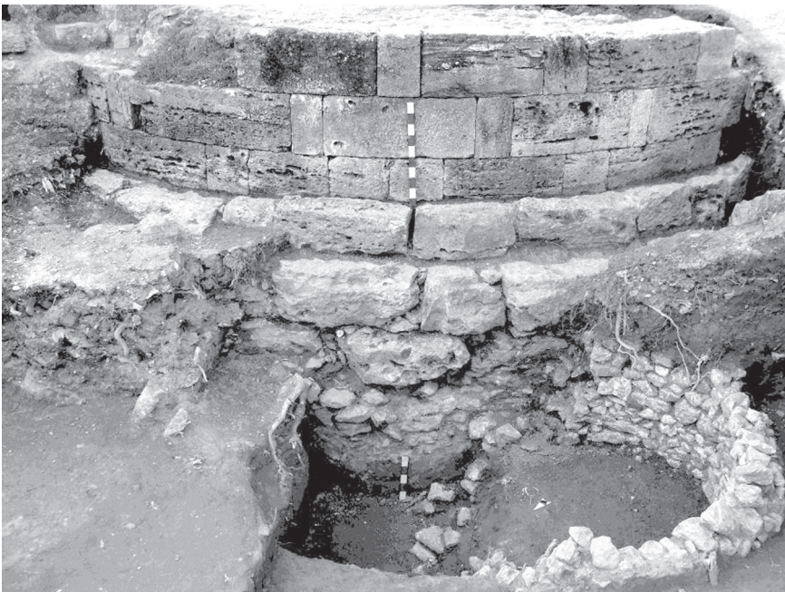
Fig. 5 - Vedere a arcului frontal al turnului de NE și a fundațiilor acestuia; în stânga imaginii, fântână din epoca modernă alipită turnului.
