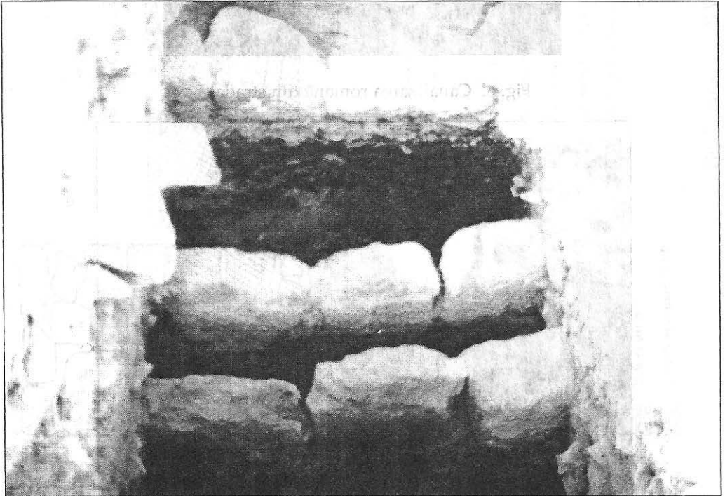
Fig. 9. Canalizarea elenistică și bordura străzii elenistice din S VI.
