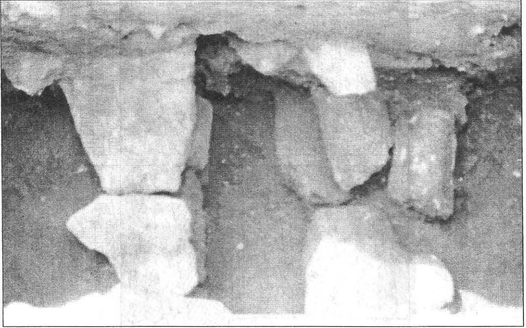
Fig. 8. Canalizarea elenistică și bordura străzii elenistice din S VI.
