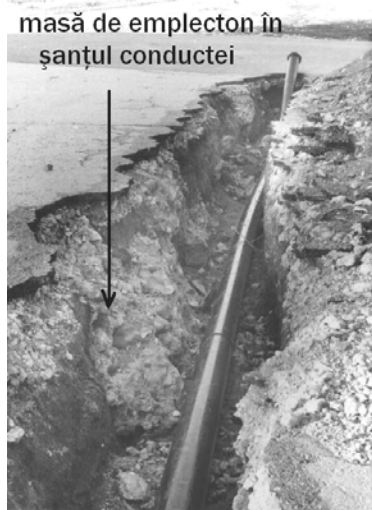
Fig. 22 – Emplectonul zidului spart de șanțul conductei.
