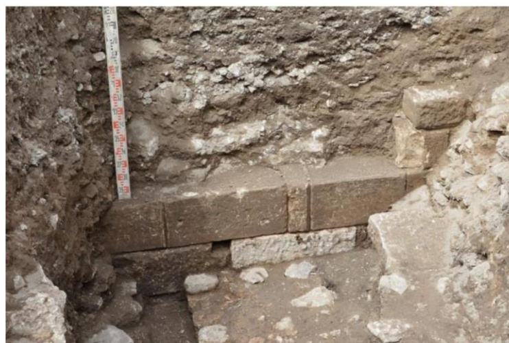
Pl. VI. Detalii de săpătură pe traseul incintei.
