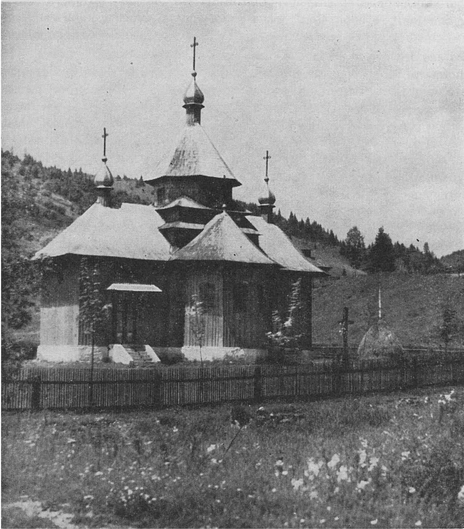
Fig. 11. — Eglise en bois de Cirlibaba (Moldavie du nord).
