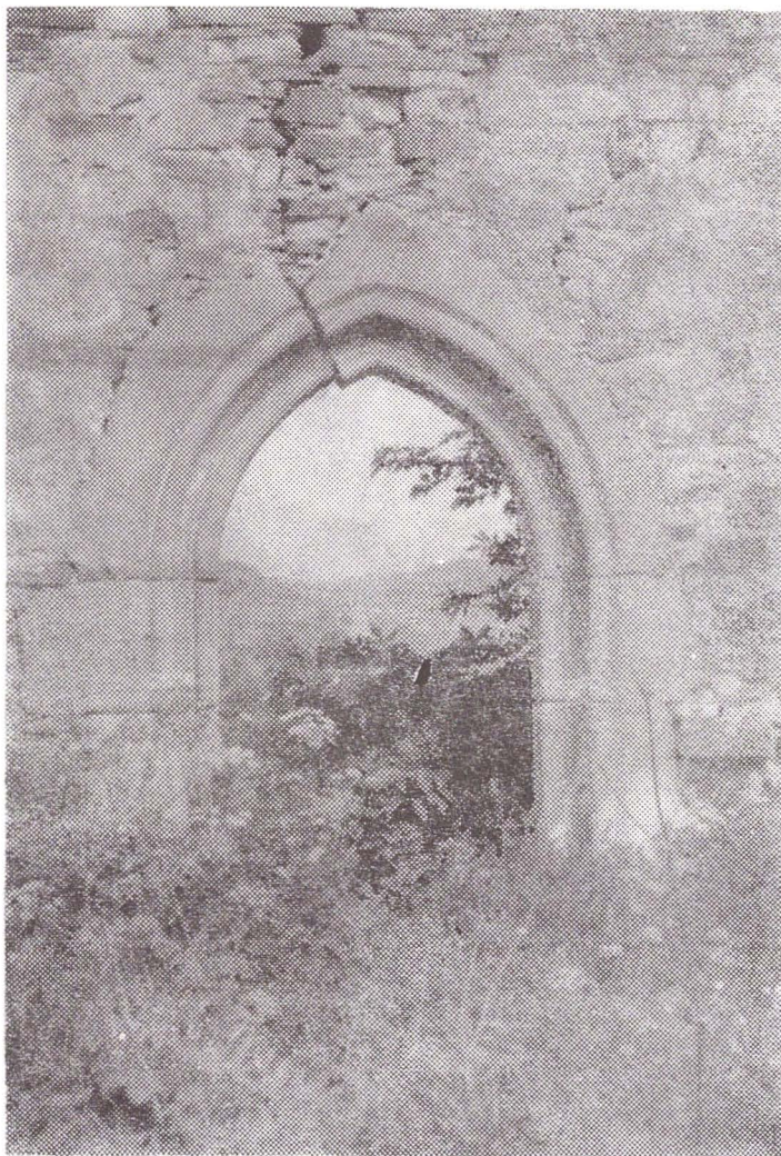
1. Portă și zid realizat din tuf vulcanic („tuf de Dej” și „tuf de Vișoara”), la biserica vârbenească din Morut (sec. XV—XVI).
