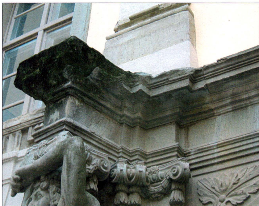
Figure 5. Black crust zones of separation and disintegration of material the main gate decoration. Figura 5. Crustă neagră cu zone de desprindere și dezagregare de material din decorul porții principale
