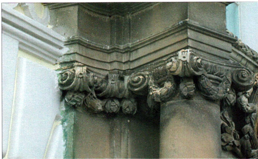
Figure 4. Black crust and detachment from aterial disaggregated sulfate attack. Figura 4. Crustă neagră și desprindere de material dezagregat în urma atacului sulfatic
