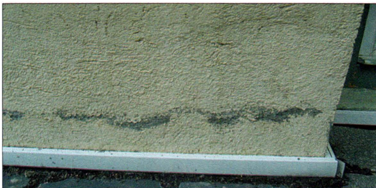
Figure 2. Finishing on a wall with bricks made of mirabilite and thenardite contaminated - photo Drăgușanu. Figura 2. Finisaj executat pe un zid cu cărămizi contaminate de mirabilite.+ thenardit – foto Drăgușanu
