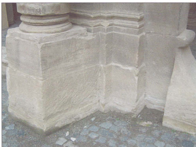
Figure 7. Accumulated salts consistent with bedding planes and the combination of block-interfaces – photo Drăgușanu Figura 7. Săruri acumulate pe plane concordante cu stratificația și pe interfețele de îmbinare a blocurilor – foto Drăgușanu
