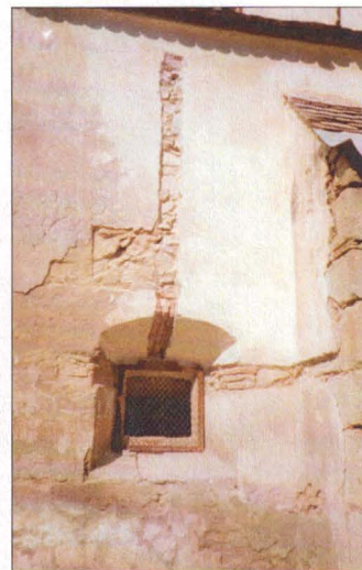
Fig. 5. Cercetări de parament de pe fațada sudică
