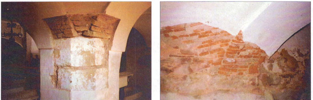
Fig. 7. Cercetări de parament în interiorul bazilicii
