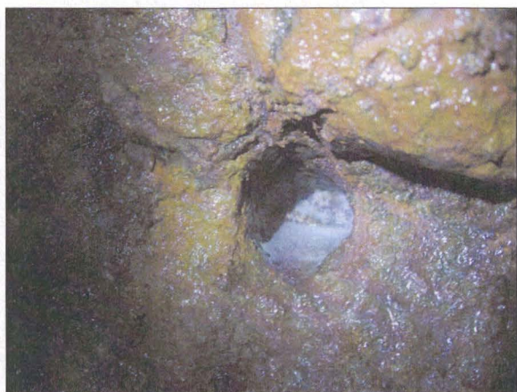
Fig. 96. Galeria 5. Gaură de mină (foto Tr. Minghiraș).
