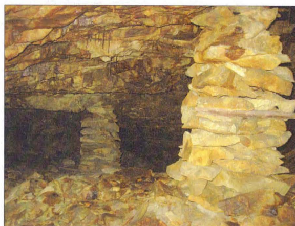
Fig. 12. Galeria +450 m. Pilieri de susținere a tavanului din blocuri stivuite (foto Tr. Minghiraș).
