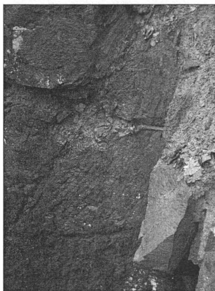
Fig. 27. „Puțul Nou”. Pereții puțului cu urme de lucrare cu dalta (foto Tr. Minghiraș).
