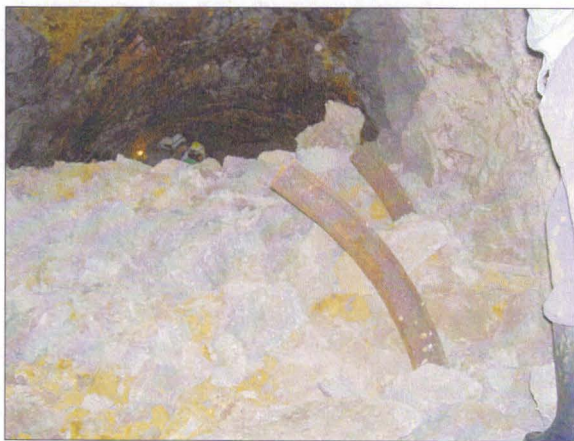
Fig. 78. Galeria Dealul Cetății. Porțiune de galerie cu prăbușiri (foto C. Kacsó).
