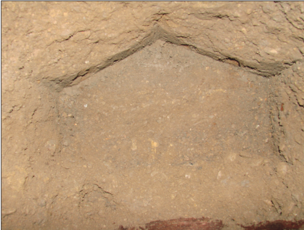
Foto 3. Caseta nr. 1. Nișa pentru lada de lemn sub fundația zidului de vest al navei vechi
