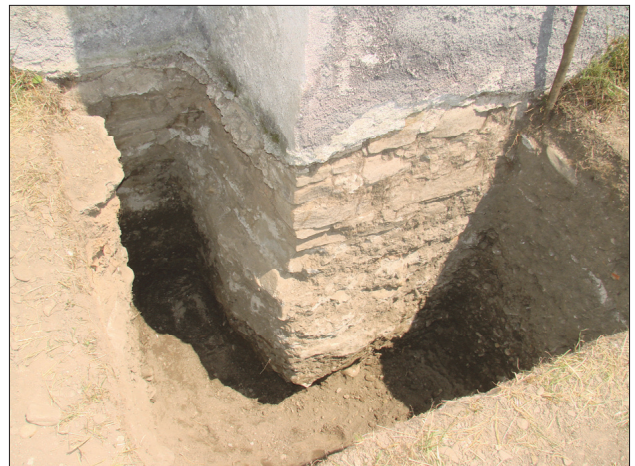
Foto 6 (cod 455). Caseta nr. 4. Fundație turn
