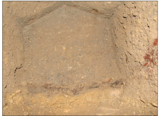
Foto 10. Caseta nr. 1. Nișa de sub fundația zidului de vest al navei
