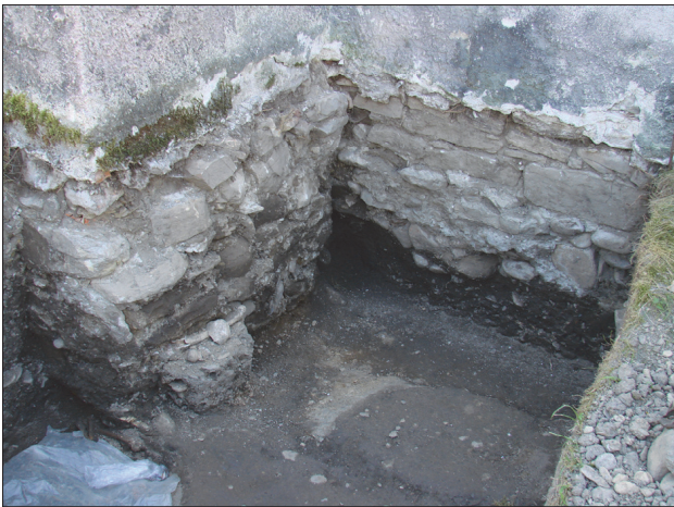
Foto 7 (cod 460). Caseta nr. 2. Contrafortul și nava
