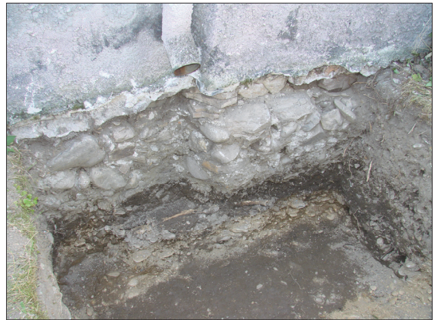
Foto 8 (cod 462). Caseta nr. 2. Contrafortul
