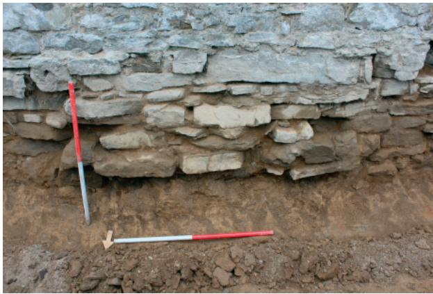
Fig. 2. Secțiunea S6, intervenții în zidăria fundațiilor.
