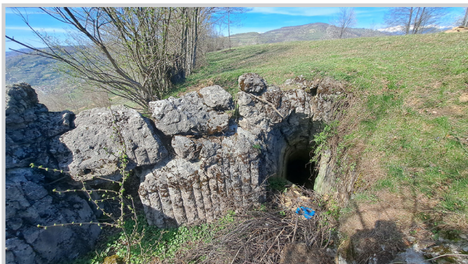
Fig. 9. Cazemată din beton și tunelul de ieșire spre ea din subteran
