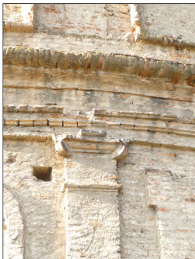
Fig. 25. Ruina bisericii Mănăstirii Giulești. Fațada Est, detaliu: pilastru, capitel, brâu, panouri. Foto arh. D. D. Ionescu 2010
