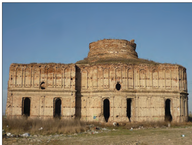
Fig. 19. Ruina bisericii Mănăstirii Giulești: latura Sud. Foto arh. D. D. Ionescu, 2010
