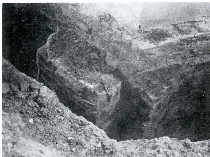
Fig. 2. Biserica Sfînta Treime din Siret. Fundația. Colțul estic al absidei sudice descoperit în timpul lucrărilor de consolidare.
