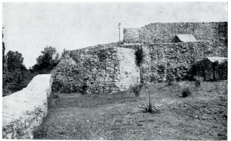
Fig. 3. Incinta de sud, turnul de sud-est.
