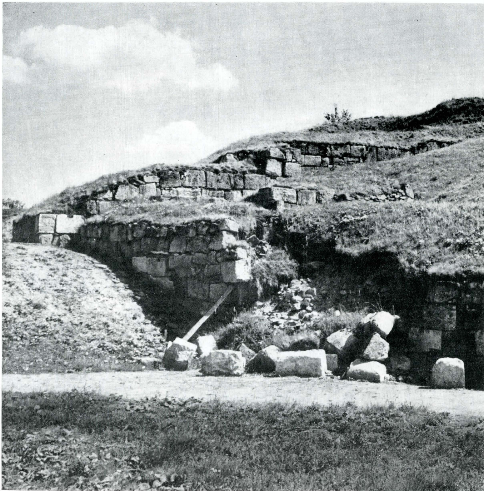
Fig. 2. Aspect de pe latura de nord a cetății Blidaru.
