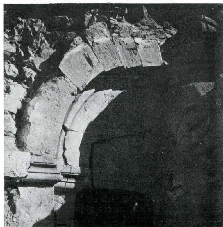
Fig. 3. Detaliu al portalului, în timpul desfacerii zidăriei de umplură.
