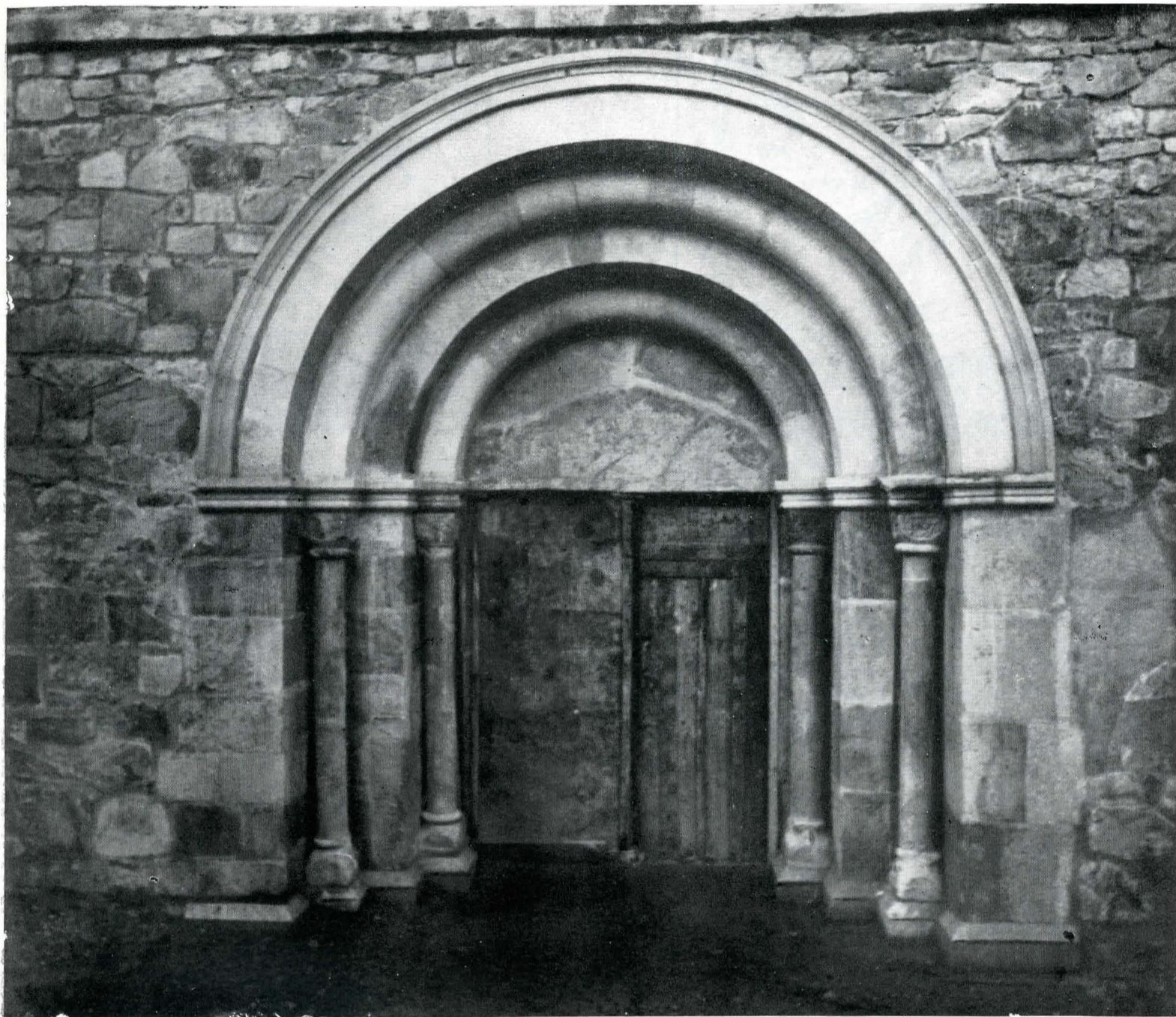
Fig. 5. Vedere a portalului restaurat.
