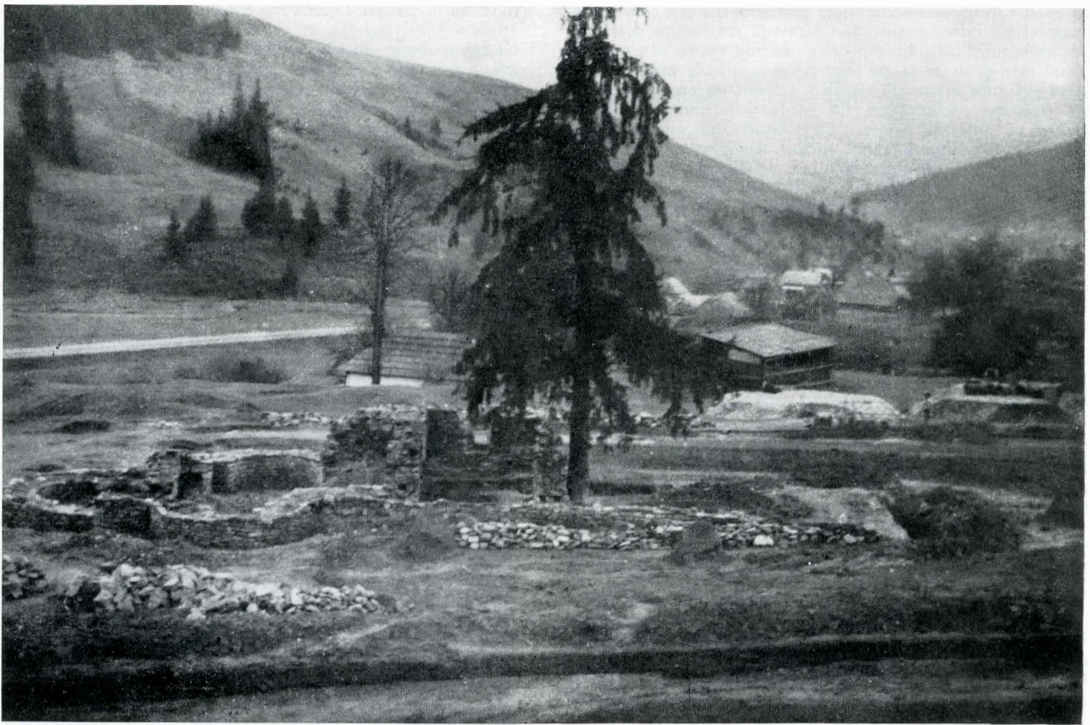
Fig. 5. Ruinele vechii mănăstiri Moldovița; Vedere de ansamblu dinspre nord, după începerea lucrărilor de consolidare.
