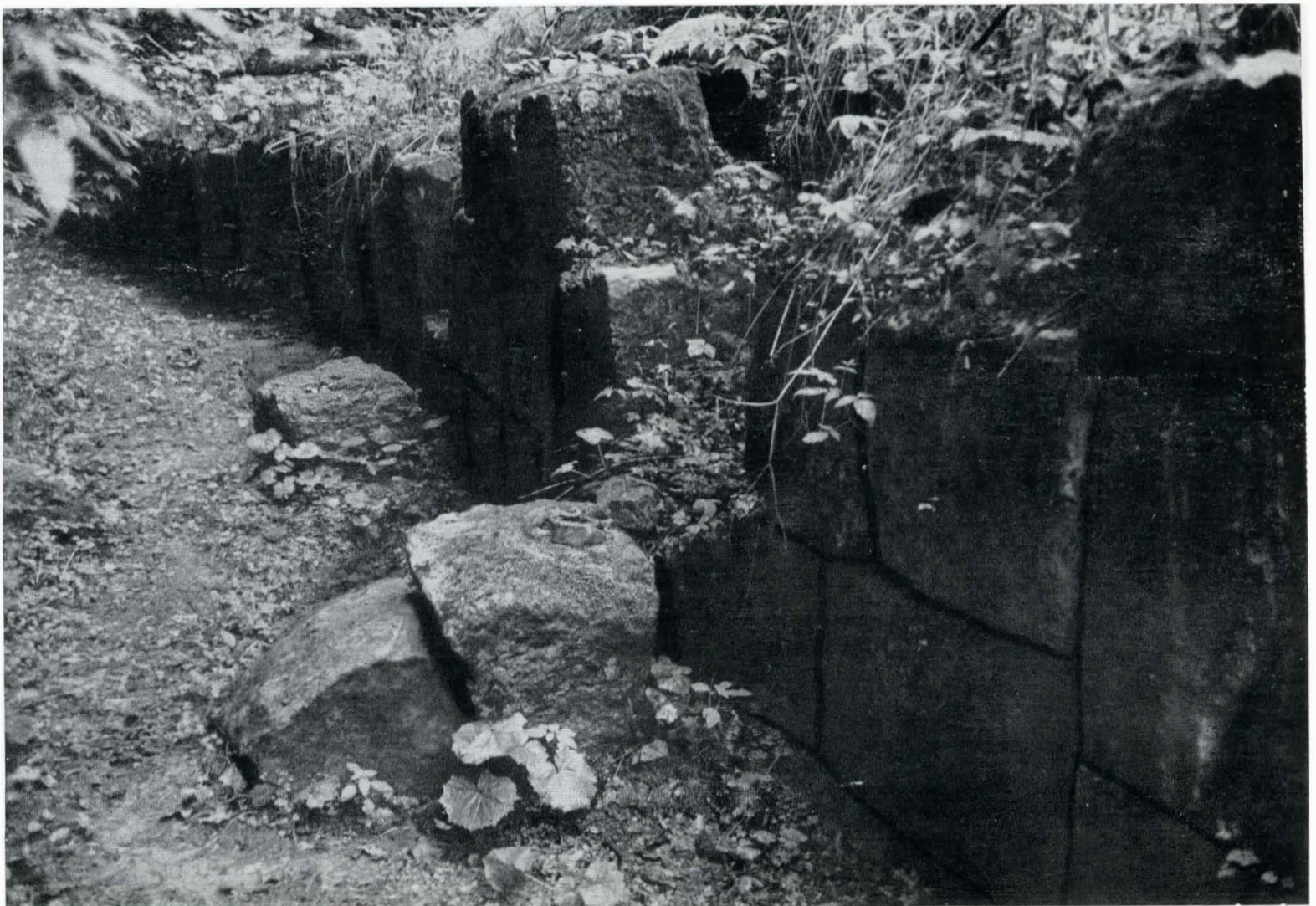
Fig. 10. Cetatea Sarmizegetusa; blocuri desprinse din zidul cetății.
