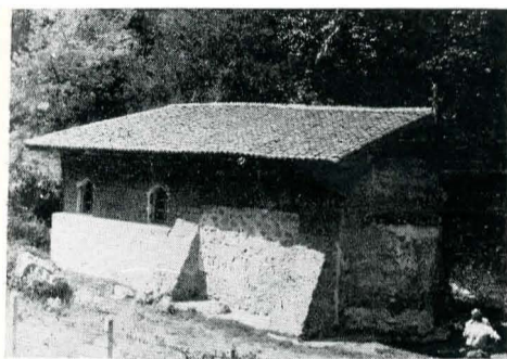
Fig. 6. Biserica Sf. Dumitru de lângă satul Baboșevo. Construită în secolul XV, prezintă un plan dreptunghiular, compartimentat în pronaos și naos, cu o mică absidă pe latura estică. Recentă consolidare a recurs la o soluție foarte incisivă, monumentul fiind îmbrăcat într-o zidărie masivă prevăzută cu contraforturi, astfel că silueta originală a fost integral modificată.
