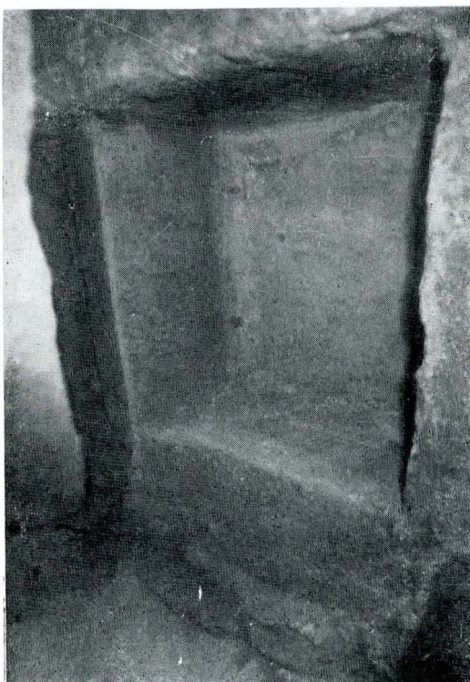
Fig. 8. Detaliu al intrării înainte de scoaterea zidăriei.
