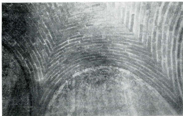
Fig. 10. Sistemul de ridicare a bolții de cărămidă, din interiorul criptei.
