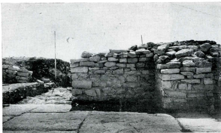
Fig. 6. Interiorul bazilicii, vedere spre sud-vest.
