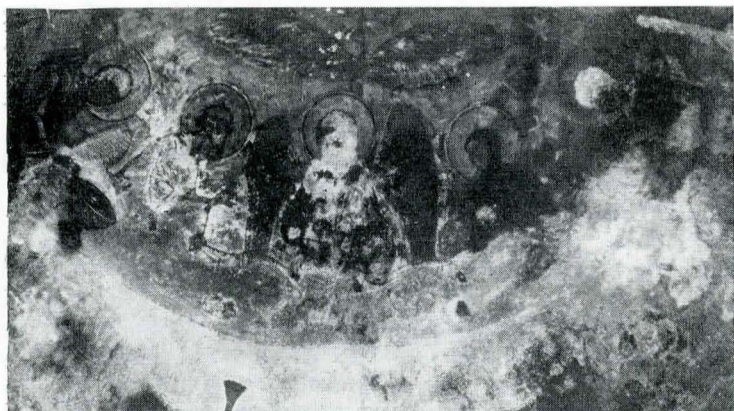
Fig. 2. Bolta absidei de sud a naosului cu scena „Cina de la Mamvri“. Zonele albe reprezintă eflorescențe.
