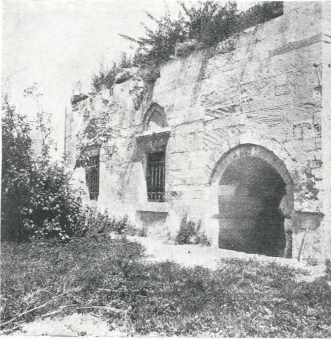
Fig. 1. — Fațada de vest cu intrarea la pivniță.
