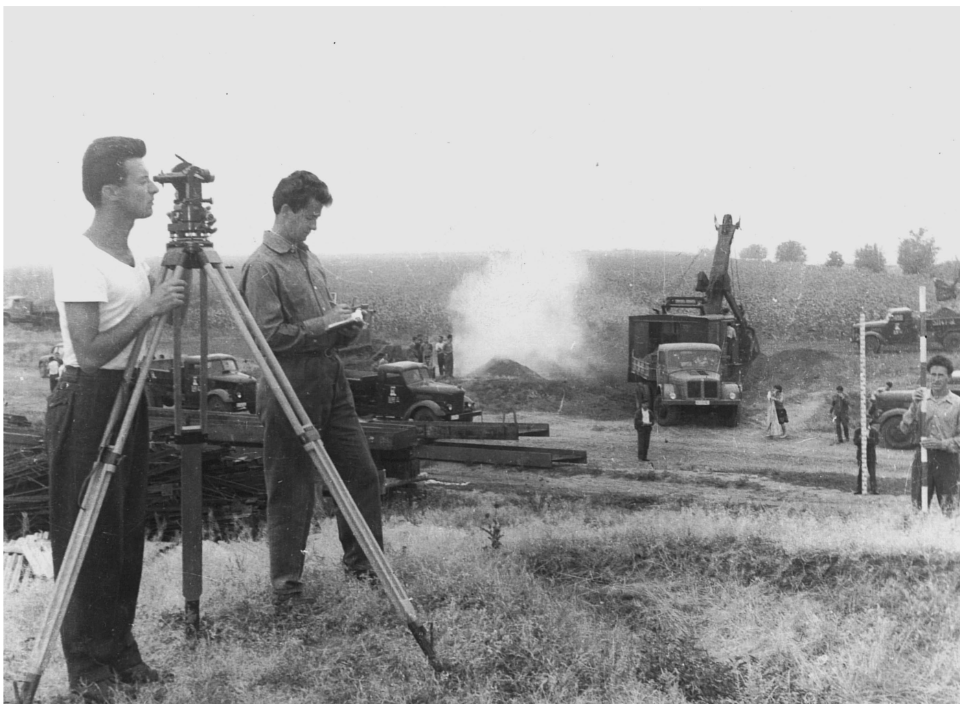
Fig 11 Lucrări de marcări topografice la începutul construcției combinatului siderurgic Galați, datat aproximativ sf. 1950 – început 1960. Sursa: Arhiva fotografică a Bibliotecii județene V.A. Urechia Galați team coordinated by arch. Paul Mihalik (Ipromet). Sursa/Source: Ladislau Adler et. al., 1964, pag. 58
