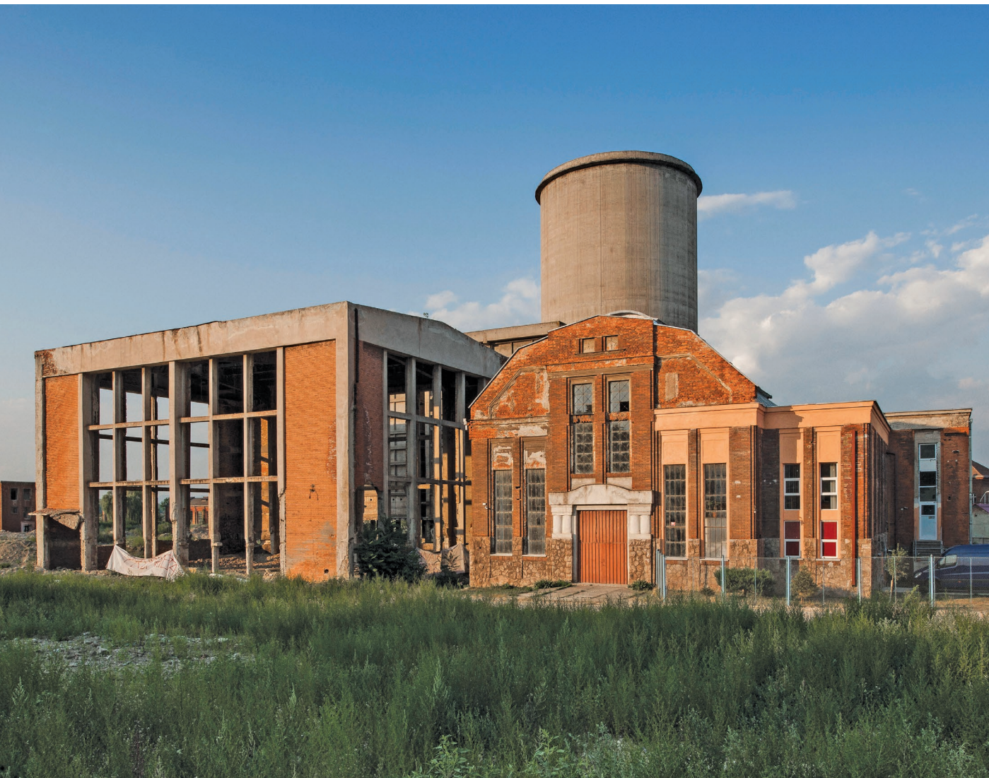
Fig 15 CTE nr. 1—Centrala termo-electrică nr. 1 construită pe situl combinatului siderurgic Hunedoara în 1915, extinsă în prima jumătate a anilor 1960. Sursa: Paolo Mazzo, 2013
