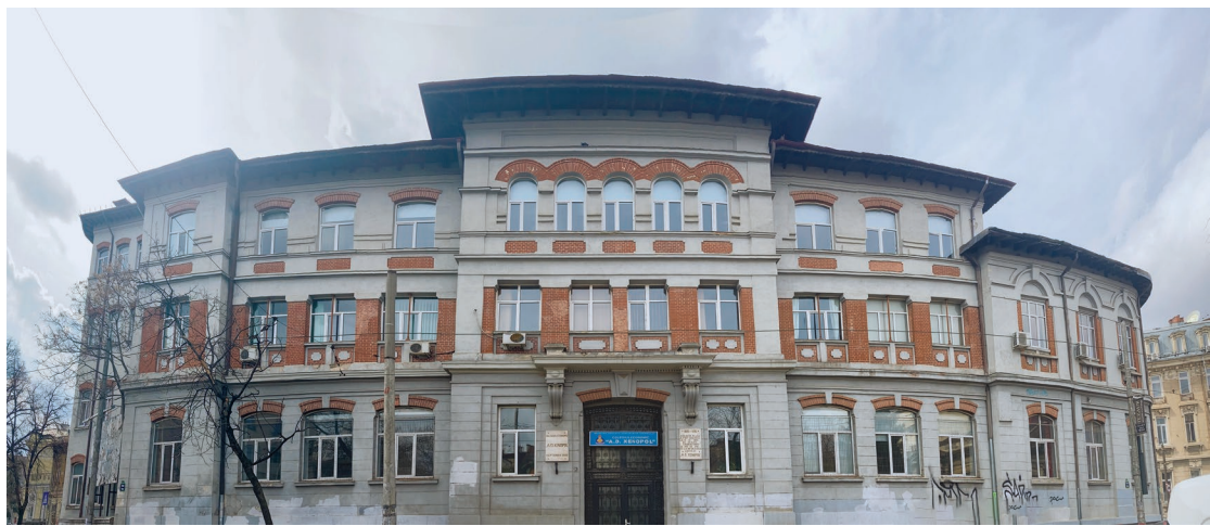
Fig. 19 Fațada corpului principal văzută dinspre str. Traian - 2021
